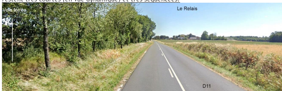
Illustration 33 : vue depuis la D11 et les abords de la voie ferrée en direction d'Argy, 400 m au nord du hameau le Relais à Pellevoisin
